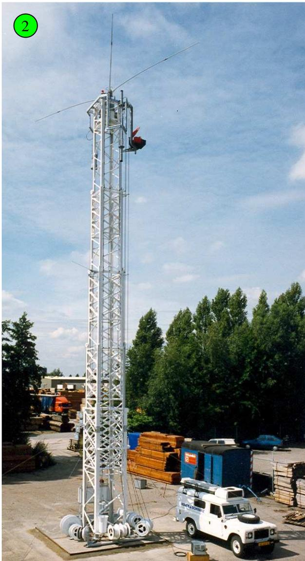
20 m Funk GTM, stationärer Aufbau
